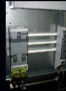
Pienjännitetila, Kabeldon-kiskosto
